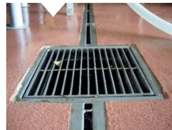
Photo 5 la nature du sol et la conception des évacuations contribuent à limiter la consommation d'eau.
