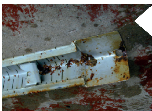
Photo 3 Encrassement particulaire (P.Poupault)
