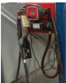
Cuve munie d'un volucompteur (remplis- sage au hangar)
